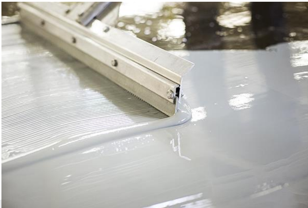
Foto: Aanbrengen vloeistofdichte beschermlaag.
